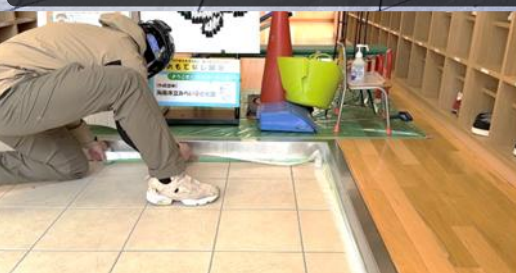
①養生作業
