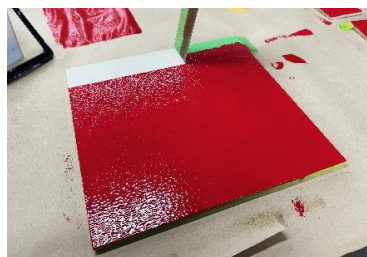
⑦硬化前に養生除去
