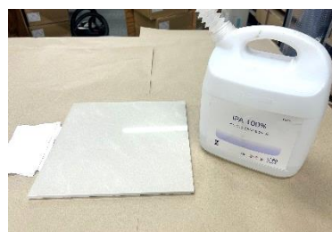
①下地調整及び脱脂作業
